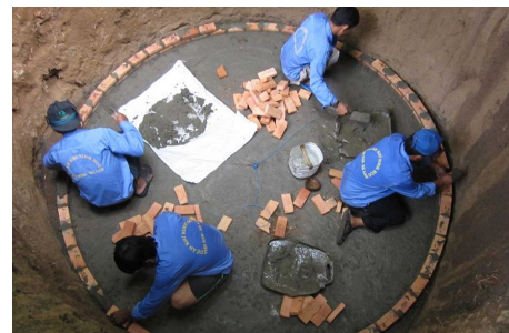
Bau einer Biogasanlage mit Ziegel und Lehm. Foto: Nexus for Development
