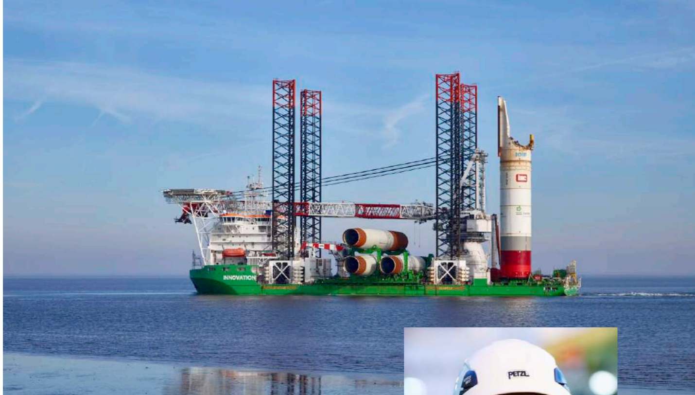
Kurs Nord-Nordwest: Ein Spezialschiff bringt die mächtigen Fundamente für die Windkraftanlagen. Stefanie Höper ist dafür verantwortlich, dass die Installation reibungslos verläuft.
